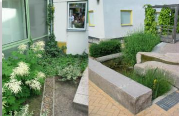
植被浅沟、雨水花园 Rain garden
