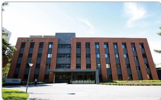
中国建筑科学研究院近零能耗示范建筑
