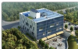
沈阳建筑大学中德节能示范中心
