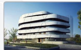
青岛中德生态园被动房技术体验中心
