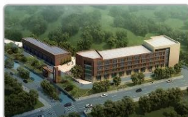
承德中天建设工程检测试验有限公司物资储备库
