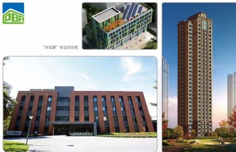
中国建筑科学研究院近零能耗示范建筑
